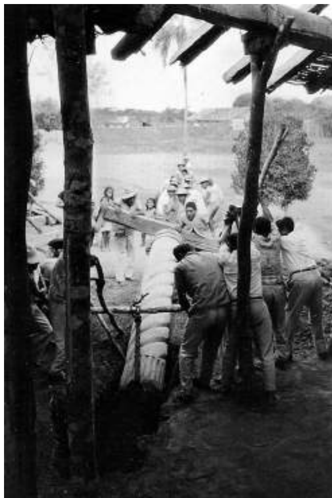
Fig. 10. Cambio de un horcón en un corredor de la iglesia de San Miguel, Chiquitania, Bolivia, 1968-70, con métodos ancestrales. Foto: Franz Greisberger.
